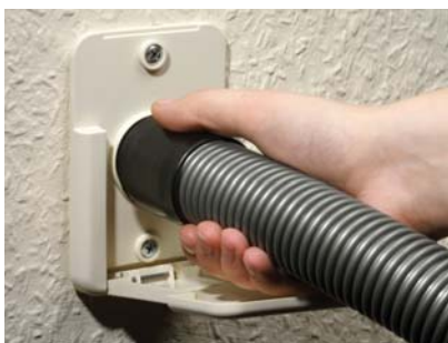
Fig. 2 Conectarea furtunului de aspirare
