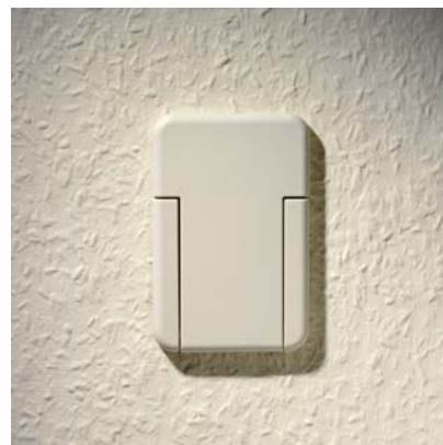
Fig. 13 Doză de aspirare instalată
